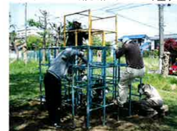
ジャングルジムの錆び落とし&ペンキ塗り
